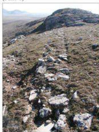
3. Lienzo de la muralla al oeste de la poterna (entrada 2).
