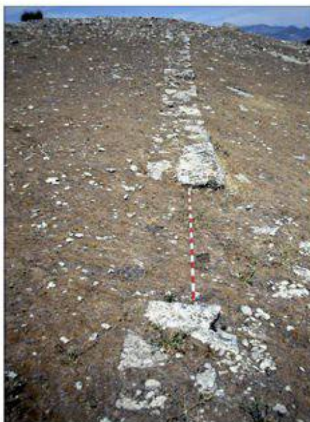
3. Poterna en el extremo occidental del lienzo norte de la muralla (entrada número 2).
